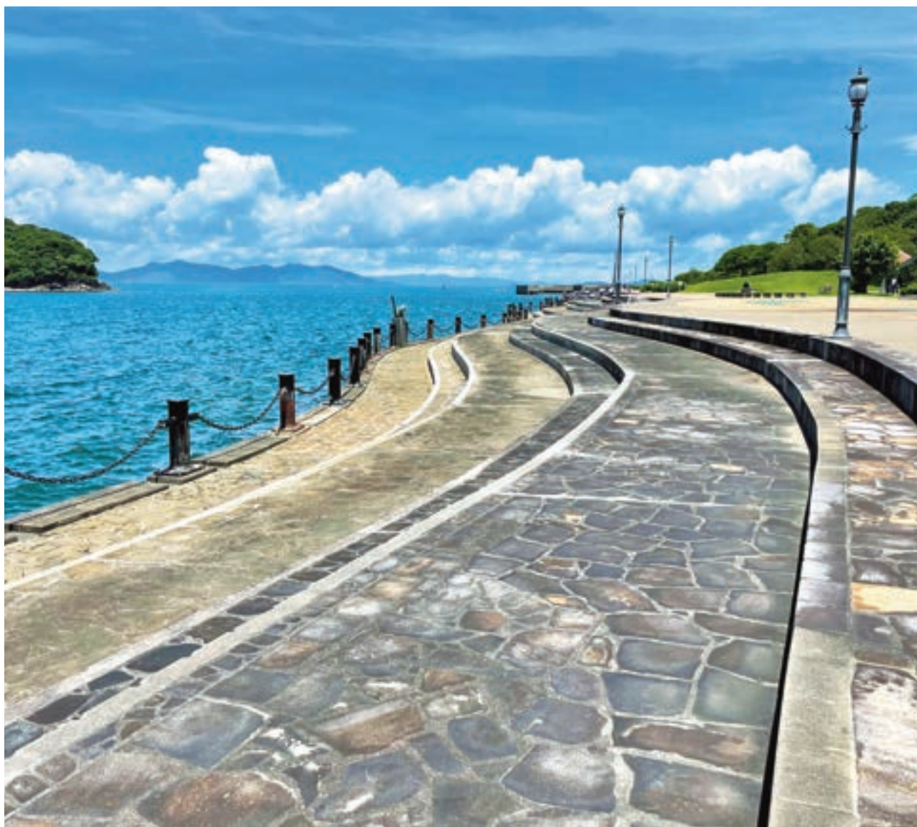
親水護岸（水俣市）
