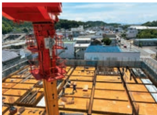
最新の建設現場の様子
